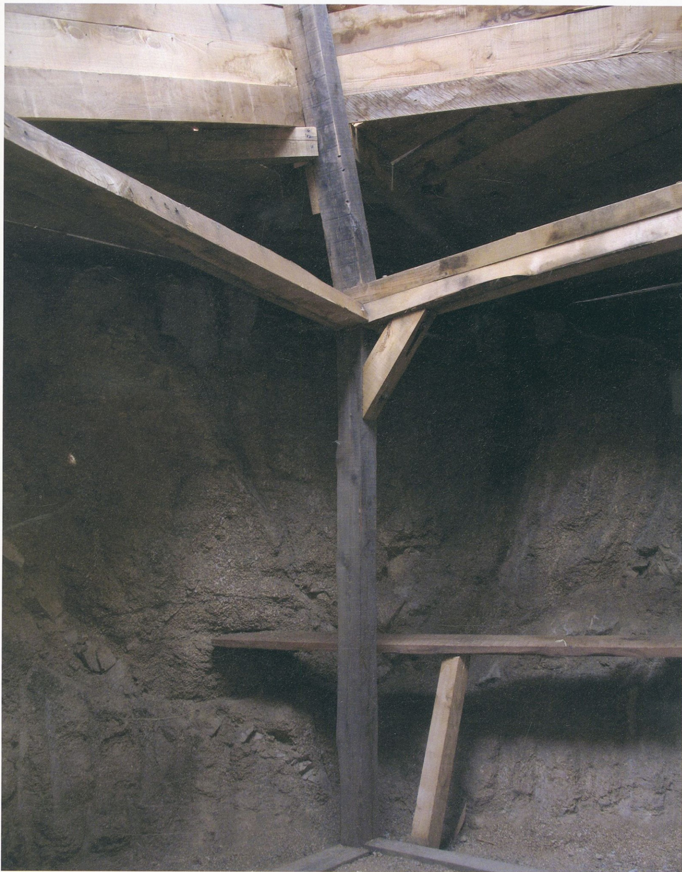
La construcción es sostenida por una simple estructura de madera. The construction is supported by a simple timber structure.
